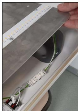
**8a** Solo per le versioni EP connettere il led emergenza ai morsetti P O dell'inverter.
